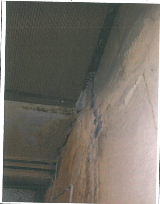
Fot. 16 - widoczne wysunięcie belki spocznika ze ściany
