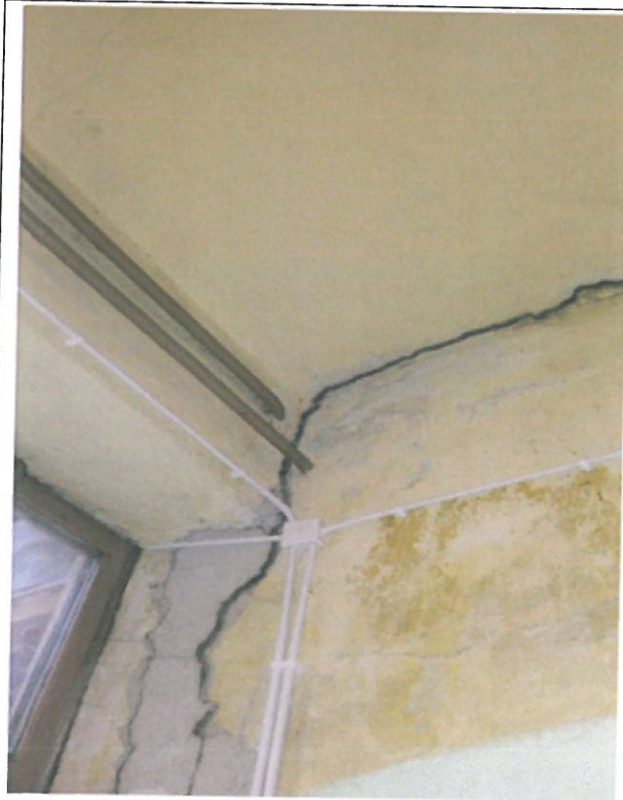
Fot. 15 - pęknięcia pod spocznikiem
