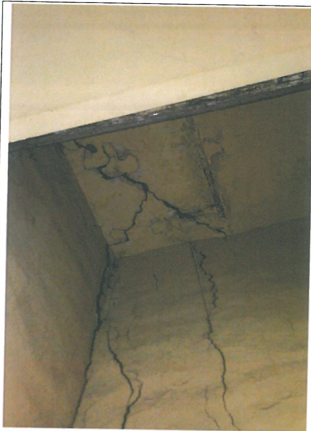
Fot. 13 - pęknięcia kozuba klatki sch.
