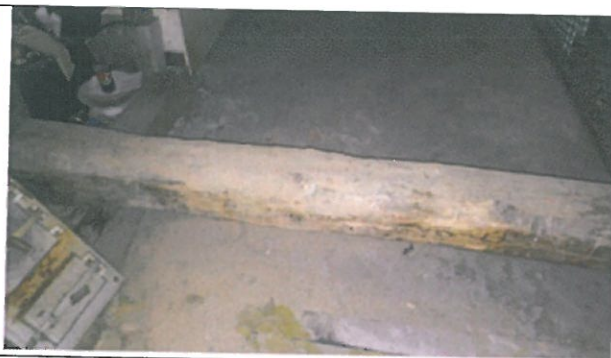
Fot. 23 - tram starty od częstego chodzenia po nim
