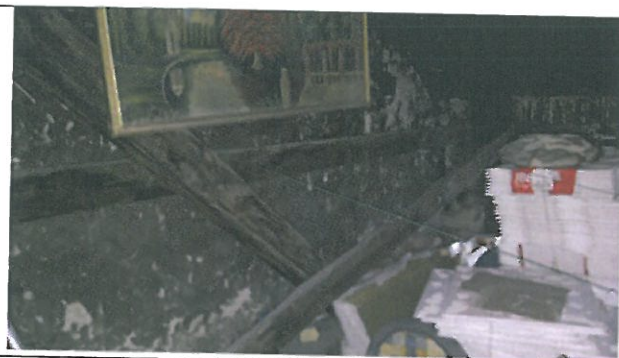
Fot. 24 - zniszczone kleszcze więźby (Jagiellońska)
