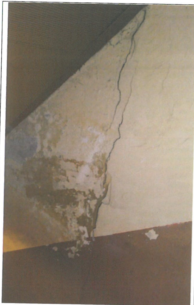
Fot. 17 - pęknięcia ściany na klatce sch.
