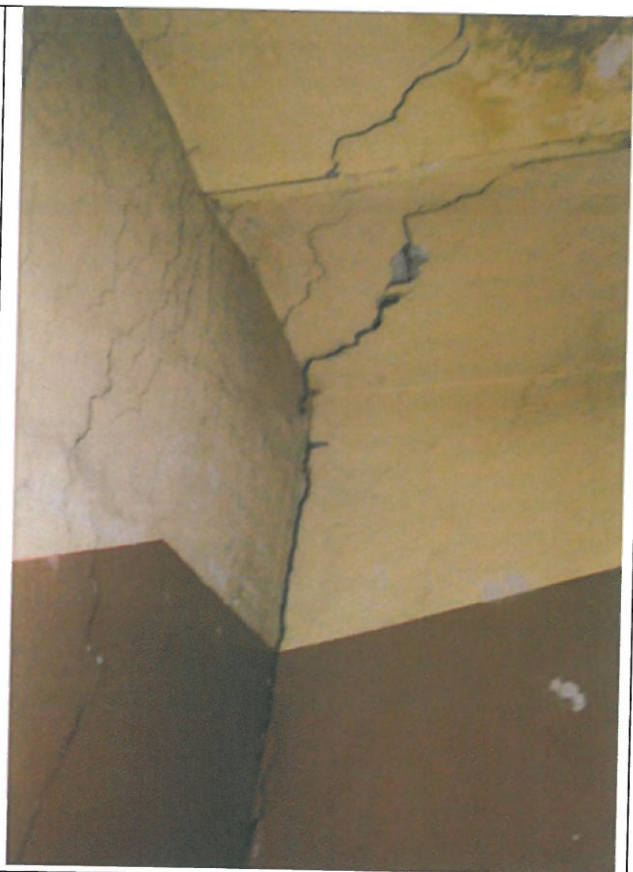
Fot. 14 - pęknięcia naroża klatki sch.
