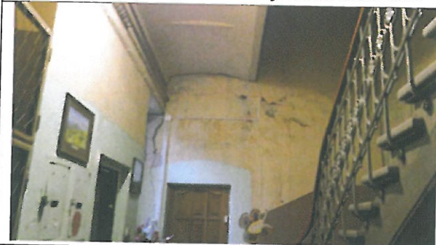
Fot. 19 - pęknięcia na klatce sch.
