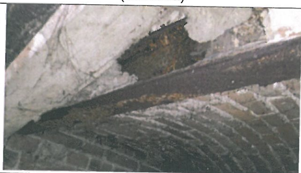
Fot. 27 - skorodowana belka stropu pod sklepem odzieżowym
