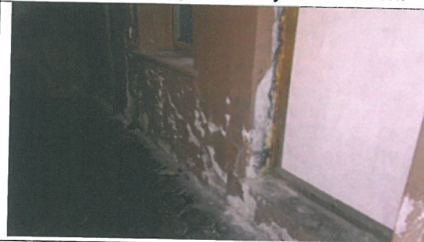
Fot. 20 - zawilgocenie ścian na kl. sch.
