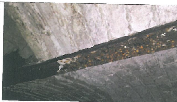
Fot. 28 - skorodowana belka stropu pod sklepem odzieżowym
