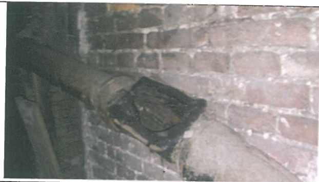
Fot. 32 - brak dekla na kanalizacji
