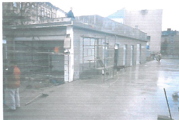
Fot. 6 Warstwa dociskowa po wykonaniu
