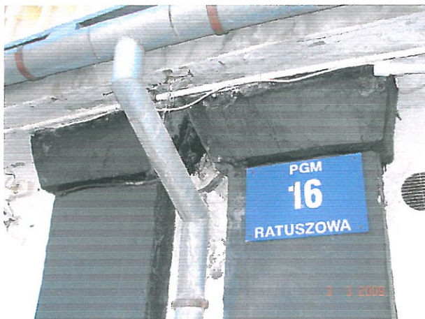
Fot. 25 Prześląkani wody z okapu gzymsu (fot. PGM Przemysł)
