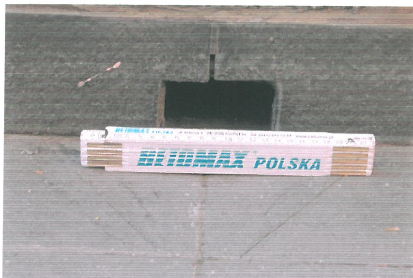
Fot. 9 Widok przykanalika odwadniającego
