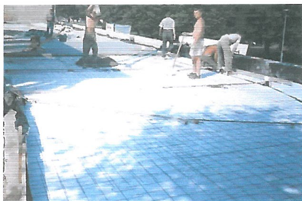
Fot. 5 Zbrojenie warstwy dociskowej
