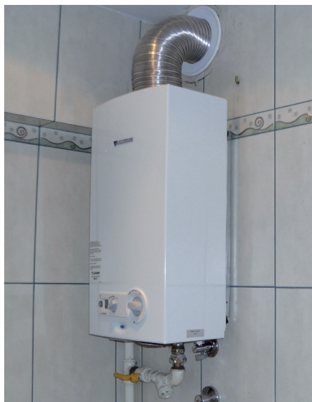
Jedno z najpopularniejszych urządzeń do podgrzewania wody - przy zaniedbanej wentylacji może stać się „cichym zabójcą”.
